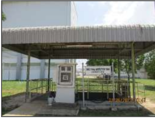
ภาพที่ 2.4 บ่อตรวจสอบคุณภาพน้ำ (Final Inspection Tank)
