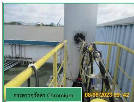
ภาพที่ 3.7 การตรวจวัดคุณภาพอากาศจากปล่อง EPL Chrome Plating (สายผลิตที่ 2)
