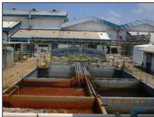
ภาพที่ 2.3 บ่อรวบรวมน้ำเสียของโครงการฯ
